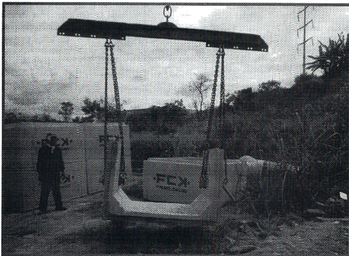
Figura 4: manuseio de canal com utilização de cambão mais correntes mais pinos.
